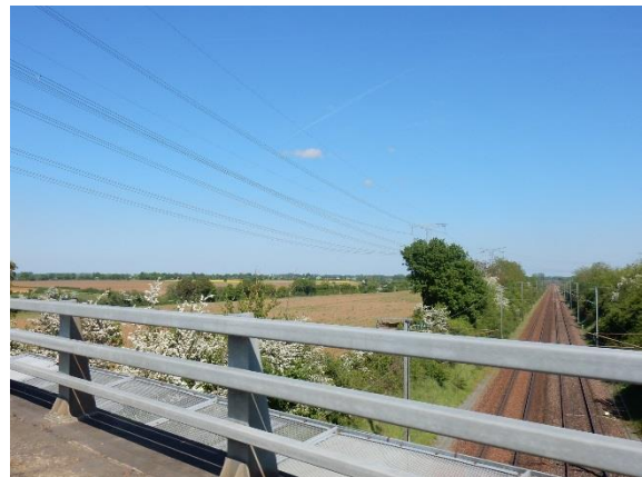
Paysage marqué par les infrastructures (Avoise)
