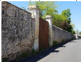
Murs de clôture_Pincé
