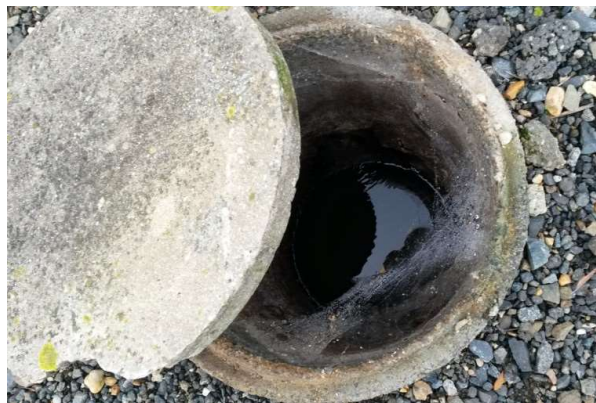
Figure 2 : Accès aux ouvrages
